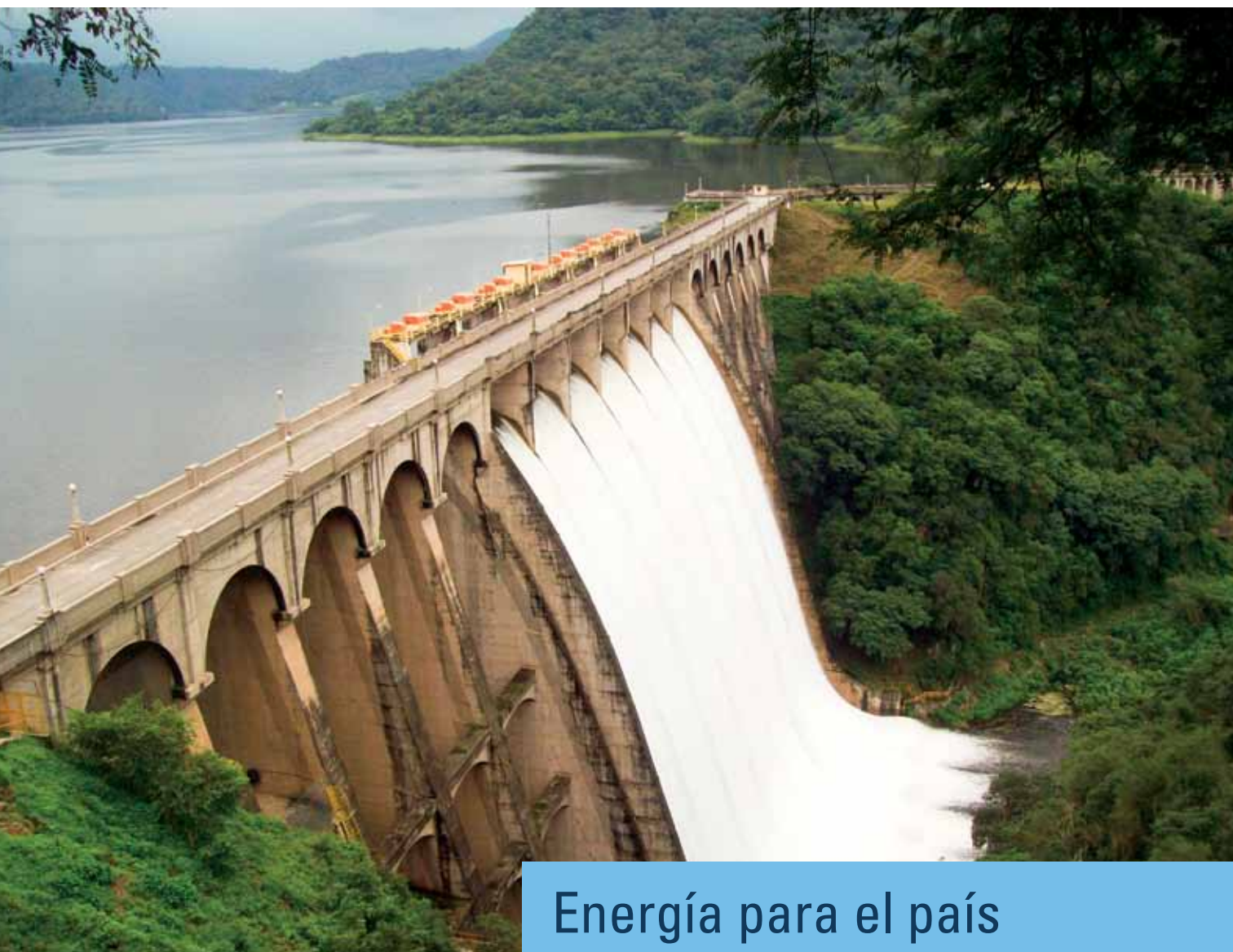
Foto: Central Hidroeléctrica Escaba
