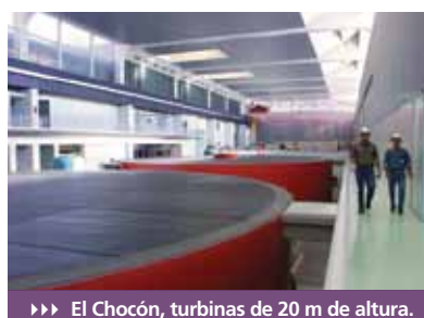
▶▶▶ El Chocón, turbinas de 20 m de altura.
