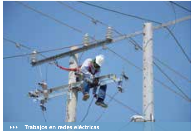
▶▶ Trabajos en redes eléctricas
