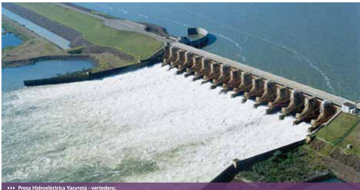
▶▶ Presa Hidroeléctrica Yacretá - vertedero.
