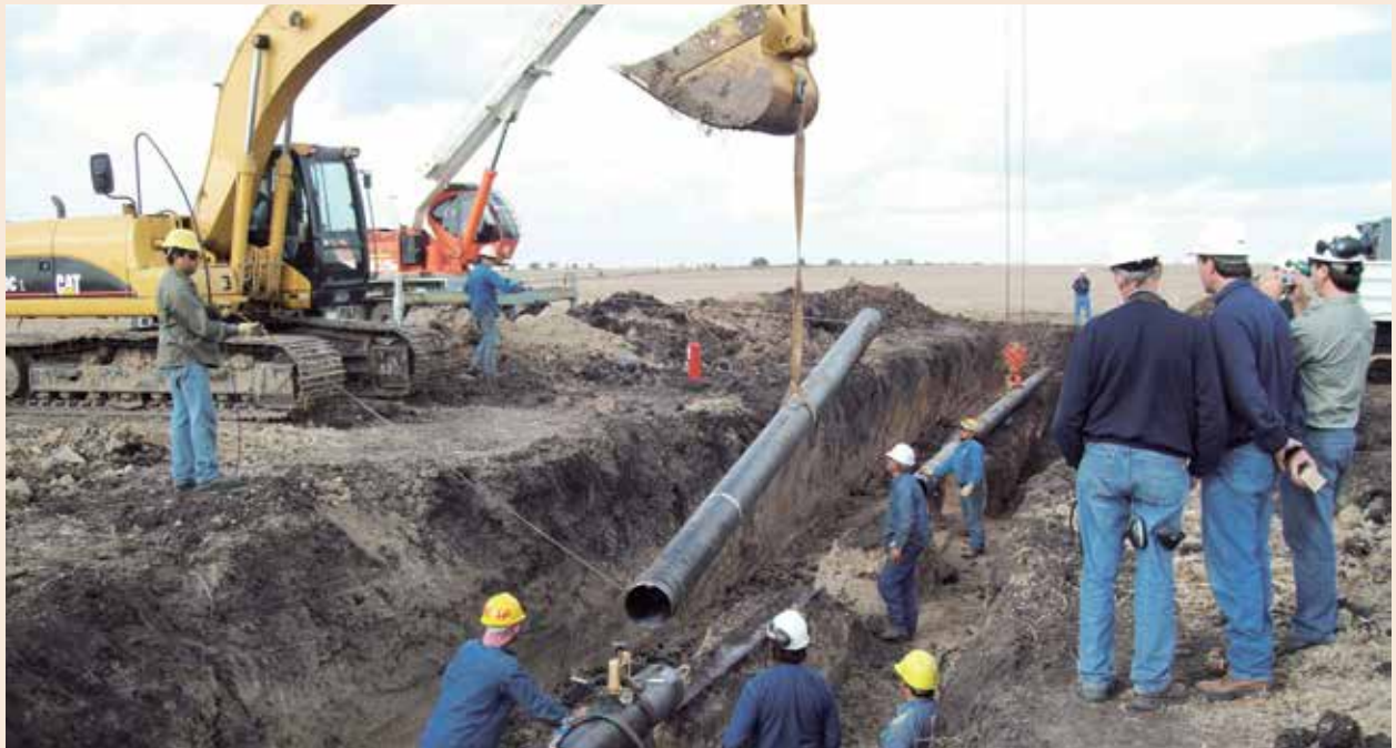
►► Obra de Gas
