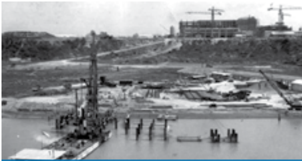
»» ATUCHA I - La construcción comienza en 1968
