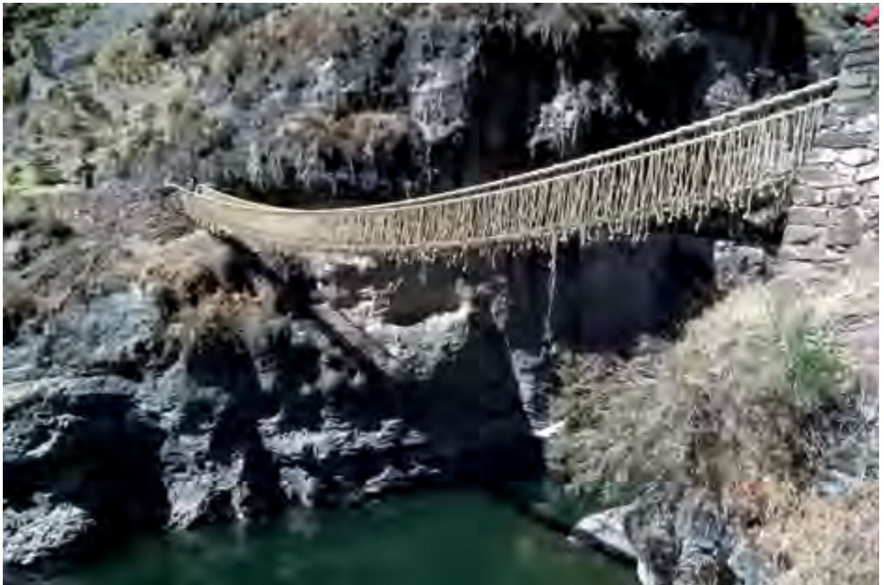
Puente colgante Q'eswachaca construido según la antigua técnica inca.
