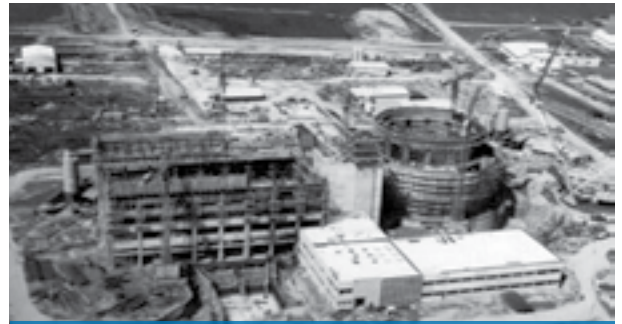
»» ATUCHA I - Avances de la construcción
